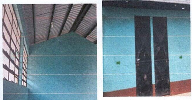
Foto 2: Mejoramiento de pintura de exterior e interior de aulas y de sanitarios
