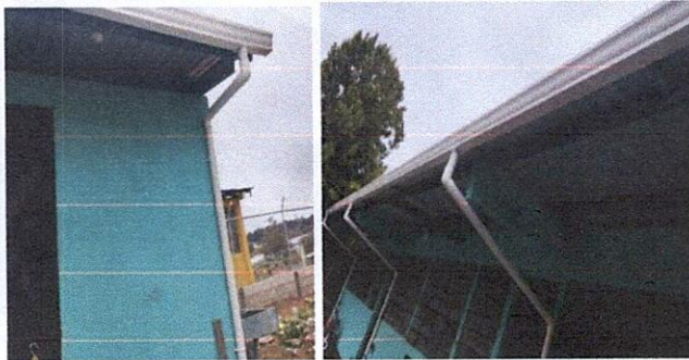
Foto1: Mejoramiento de canales y bajadas de agua pluviales en sanitario y aulas
