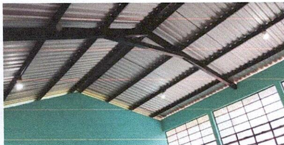
Foto 3: Mejoramiento de iluminacion en aulas
